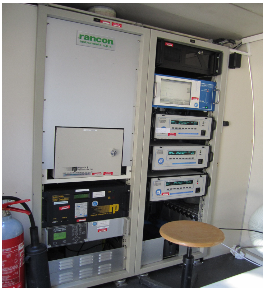
LABORATORIO MOBILE - ANALIZZATORI
