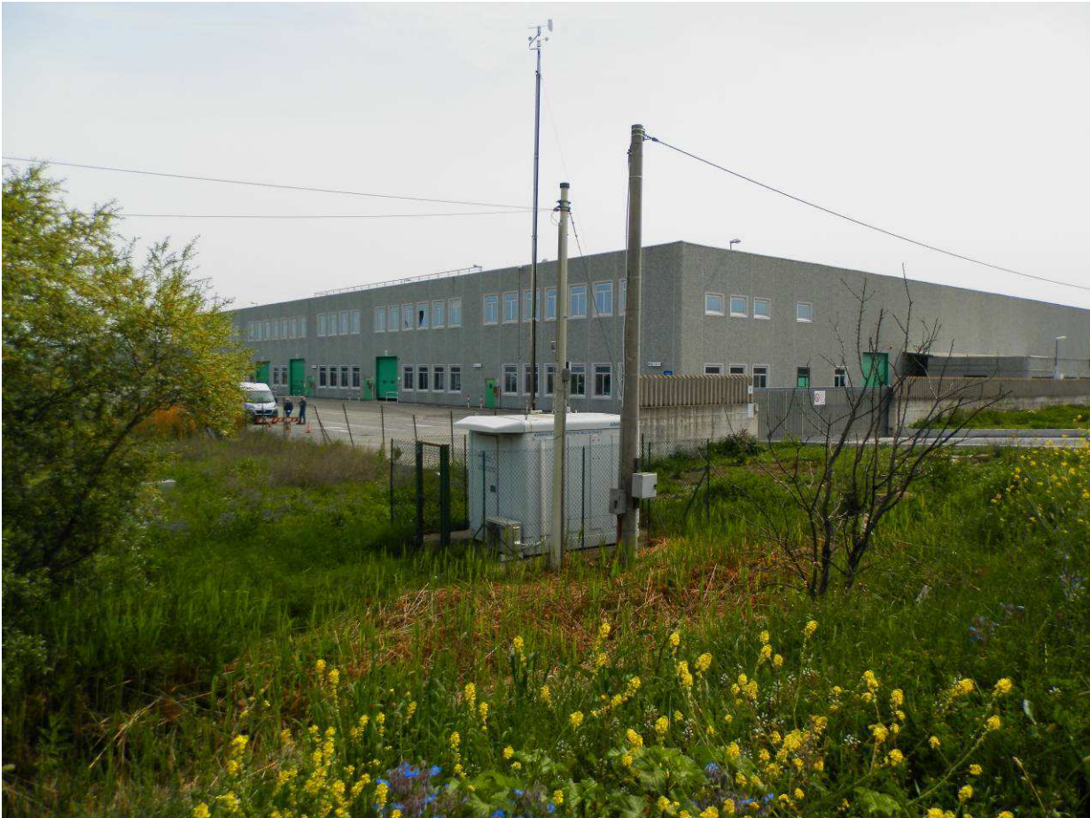
Stazione di Monitoraggio della Qualità dell'Aria – Zona Industriale Atesa – Via Catania n° 24 Contrada Saletti.
