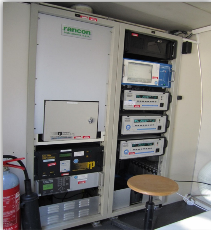
LABORATORIO MOBILE - ANALIZZATORI
