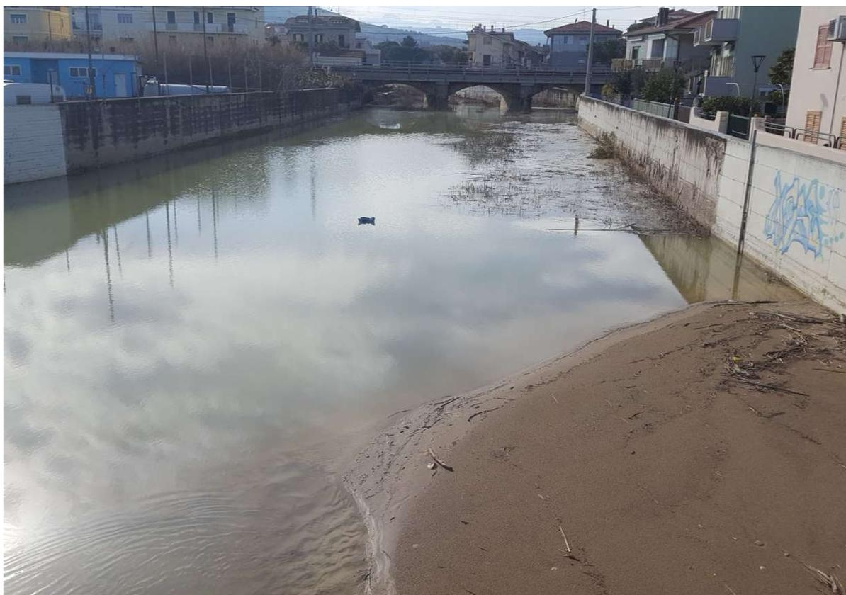
7 - Ponte Girevole. Restringimento sezione ponte ferroviario; da 5 a 3 campate
