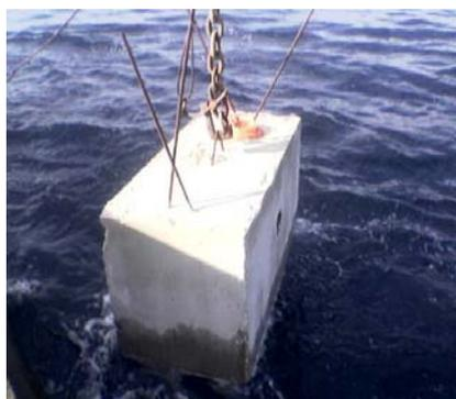
Le varie strutture sono state rese disponibili ad una possibile colonizzazione da parte di riproduttori perché dotate di specifici anfratti, buchi ed aperture dove molte specie di molluschi o pesci possono ripararsi o avere delle tane.
