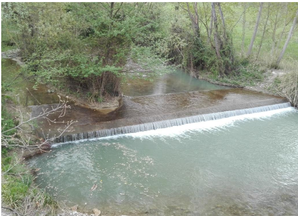
Fig. 8. Corpo idrico CI_Tordino_3: opera trasversale del tipo “Soglia”.
