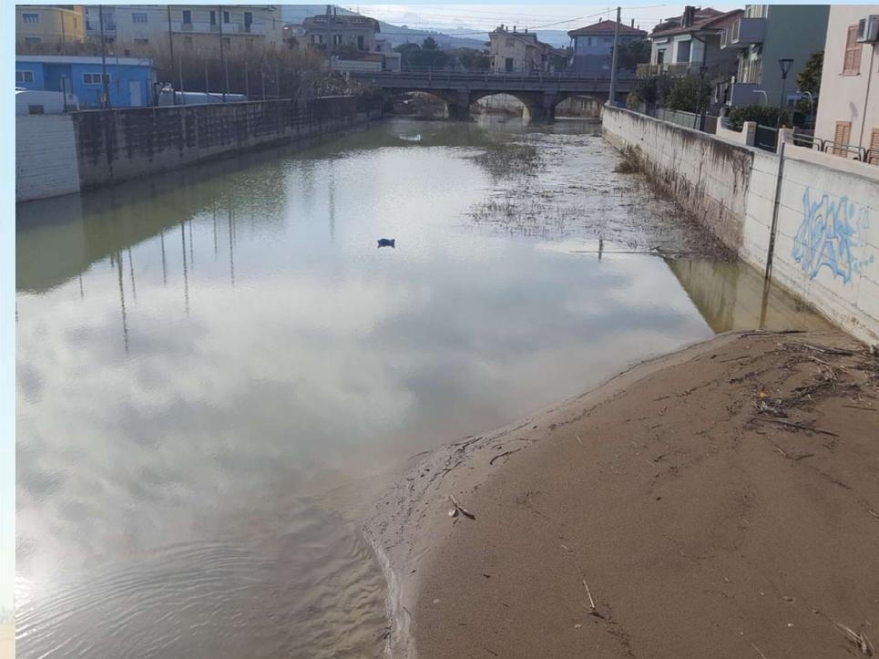
Ponte Girevole. Restringimento sezione ponte ferroviario; da 5 a 3 campate
