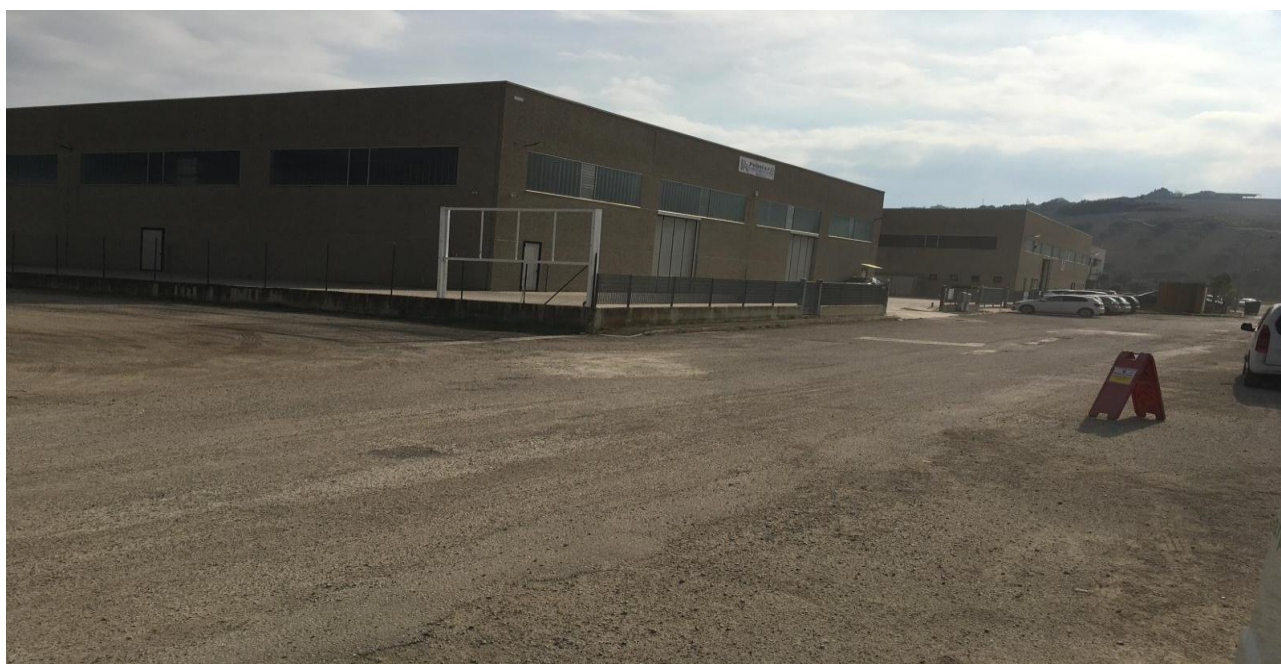
Fig. 4 Strada non asfaltata accanto al laboratorio mobile
